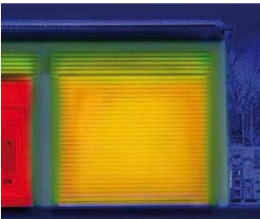
Diese Wärmebild-Aufnahme eines gewöhnlichen Rolltors zeigt deutlich den großen Wärmeverlust nach außen.
